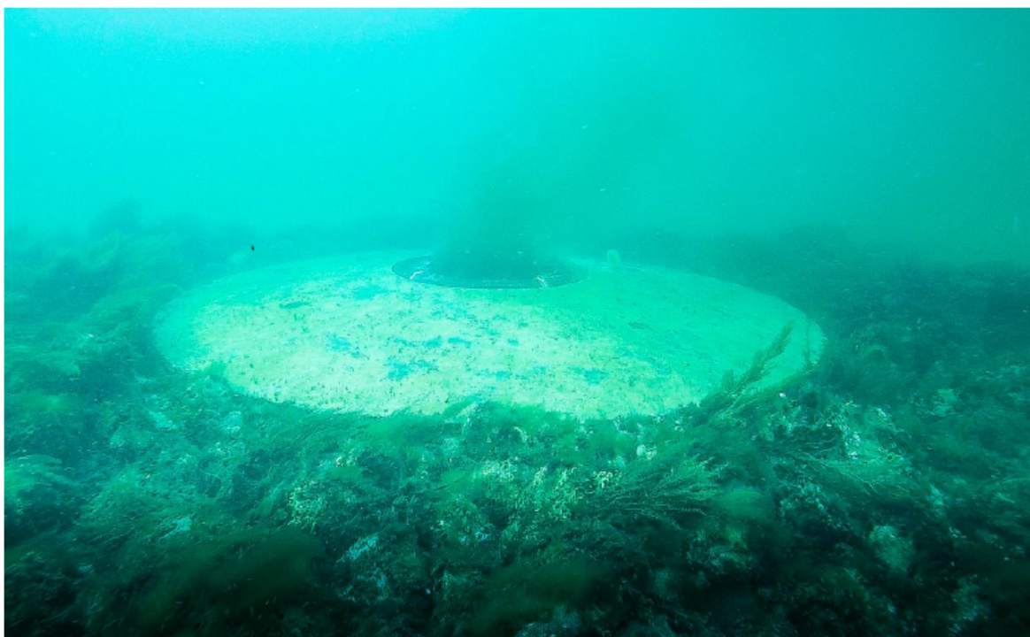
Figur 3-6 Billede af udløbsbygværket fra rapport: Kontrolundersøgelser 2019 – kortlægning og kontrol af påvirkningszone omkring udledningsledningen fra Mariagerfjord Renseanlæg, Mariagerfjord vand A/S 15.04 2020.
