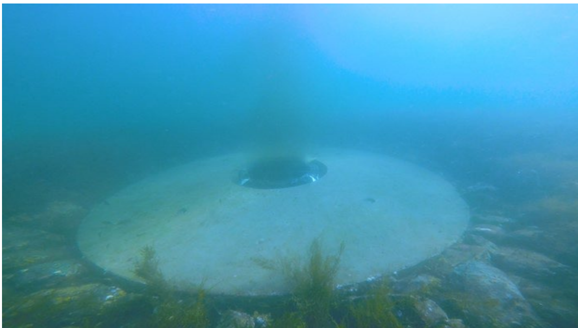
Billedet viser udløbsledningen fra Mariagerfjord Renseanlæg efter rensning af begroning på ringarmeringen (Mariagerfjord Vand A/S, 2022b).
