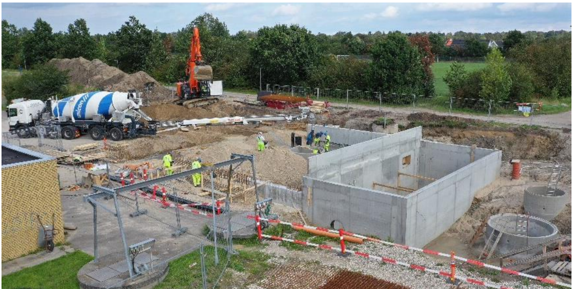
Eksempel på udgravning og støbearbejde.
