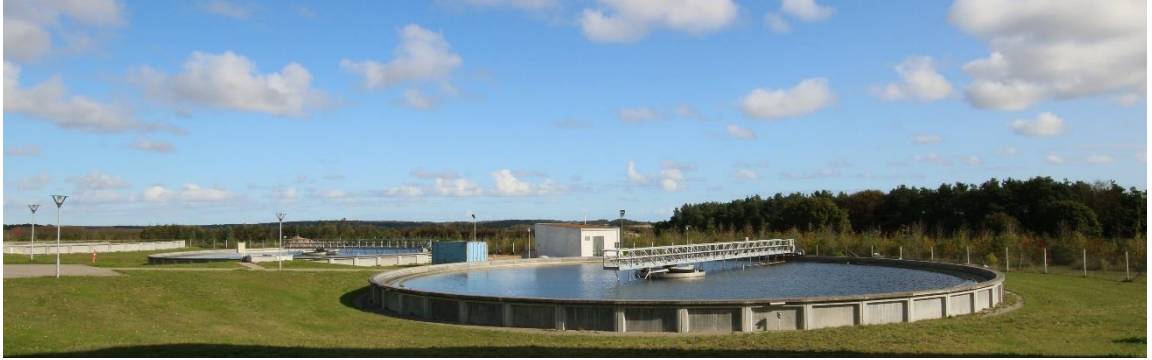
Mariagerfjord Renselanlæg © Mariagerfjord Vand A/S.
